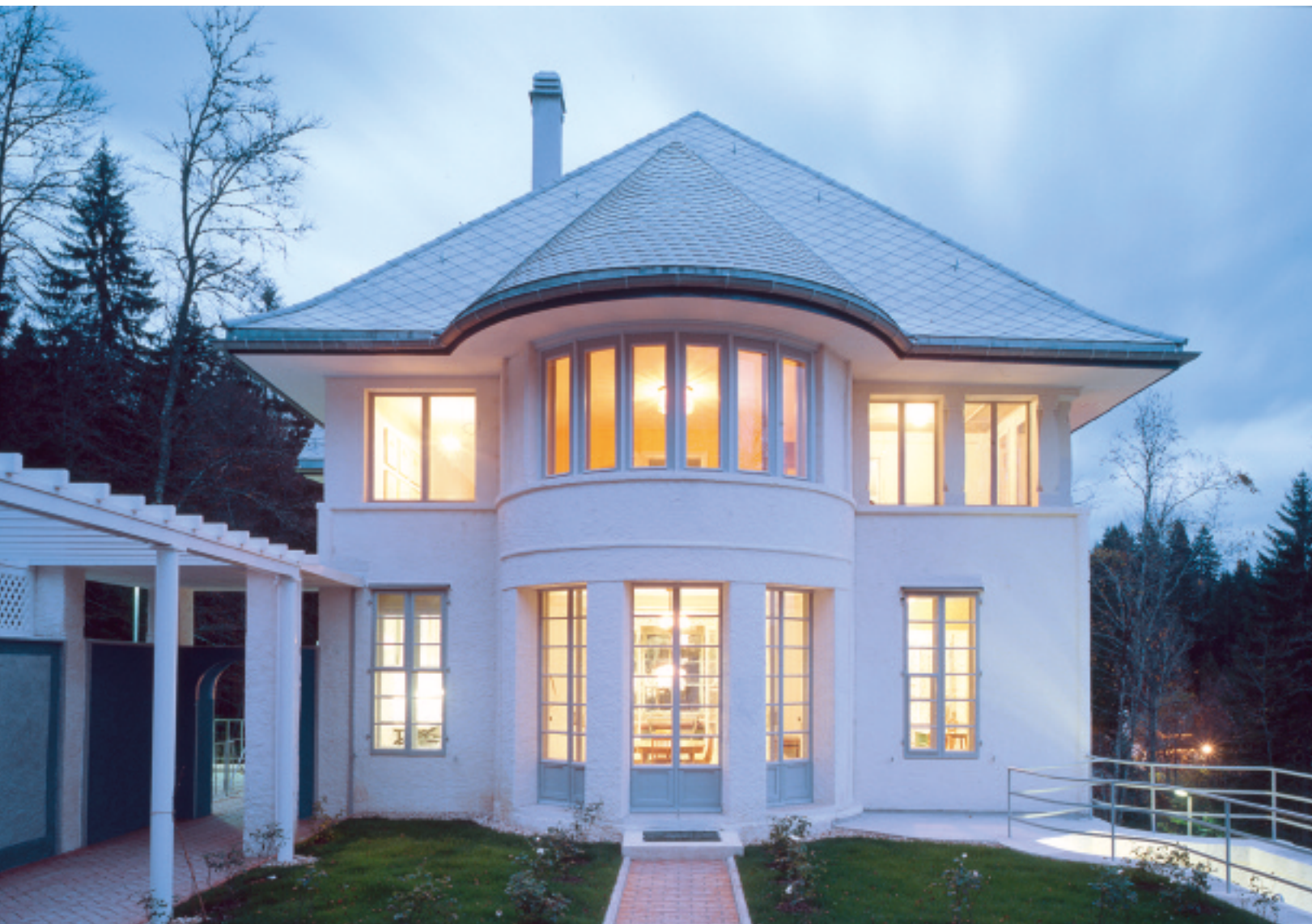
Un toit en fibrociment (Eternit) conférait à la Maison blanche un aspect léger aérien. Les tuiles posées plus tard (années 1940) subsisteront jusqu'en 2004. La restauration a redonné au toit son aspect d'origine.
